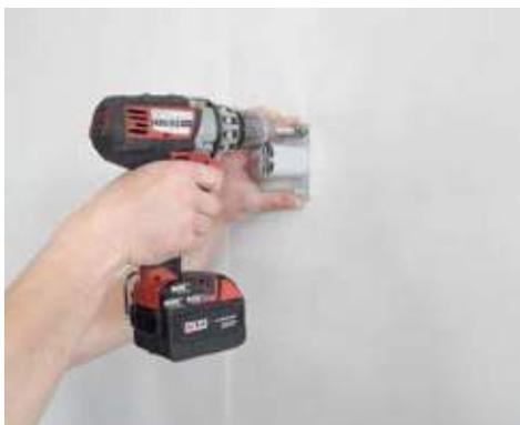
2. Bohren Sie die Löcher und schrauben Sie anschließend die Halter mit entsprechendem Befestigungsmaterial fest.
