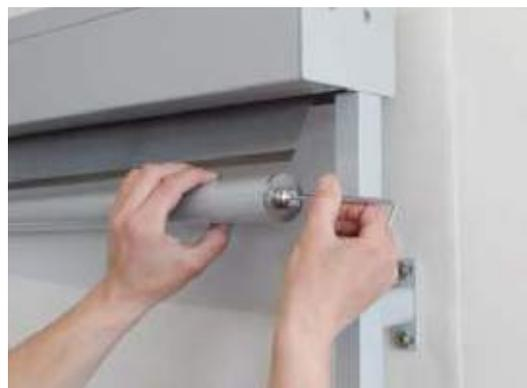
3. Schließen Sie den Antrieb an die Stromversorgung an und fahren den Behang herunter. Anschließend lösen Sie die Schrauben im Fallprofil, um den beweglichen Teil am Fallprofil zu montieren.
