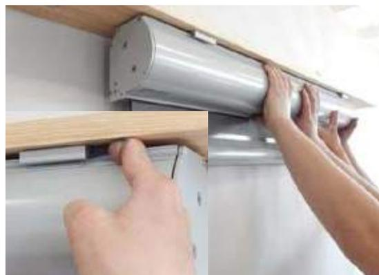
2. Bringen Sie die Kassette an den vorher angebrachten Und waagrecht ausgerichteten Montageclips an. Arretieren Sie anschließend die Kassette mit dem Blockadelement in den Montageclips.
