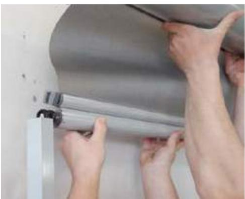
3. Führen Sie das Fallprofil, das Windschutzprofil und die Kassette in die Führungsschienen.
