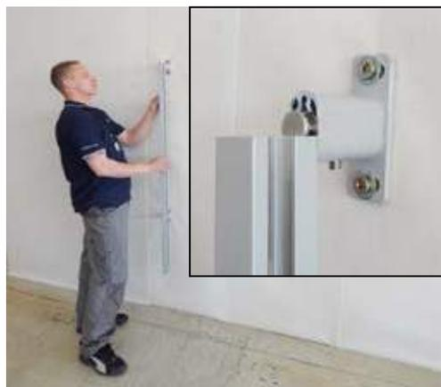
7. Schieben sie die Führungsschiene mit der hinteren Rille über die Metallzapfen.
